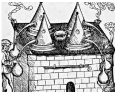
Appareils distillatoires avec cornues coiffées de chapiteaux coniques pour recueillir les eaux distillées, in Jérôme Brunschwig, Liber de arte distillandi , 1512
